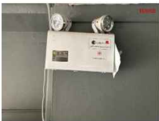
ภาพที่ 2.2-15 ระบบไฟฟ้าส่องสว่างฉุกเฉิน
